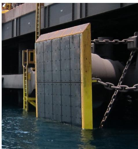
Il **PE-UHMW**, polietilene ad altissimo peso molecolare, è diventato il materiale di scelta per i rivestimenti dei pannelli frontali in acciaio dei fender, dove è richiesta la combinazione di altissima resistenza agli urti e all'abrasione, con un basso attrito del pannello.
